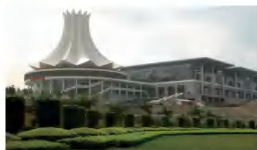
南宁国际会展中心 使用我公司生产的电线电缆
