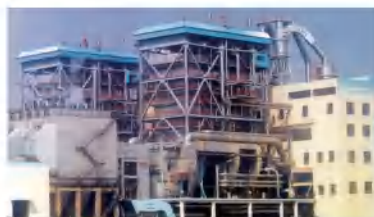
国电永福电厂 使用我公司生产的计算机电缆、无卤低烟阻燃控制电缆
